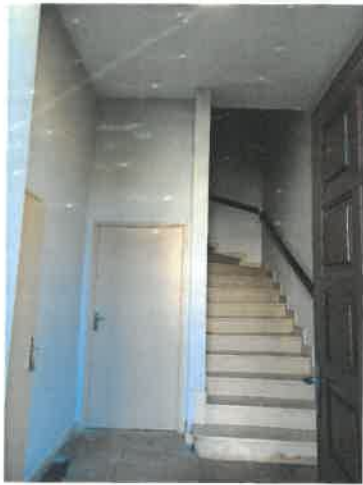
Peinture de la cage d'escaliers menant aux appartements communaux. Montant HT : 12 321,07 €
